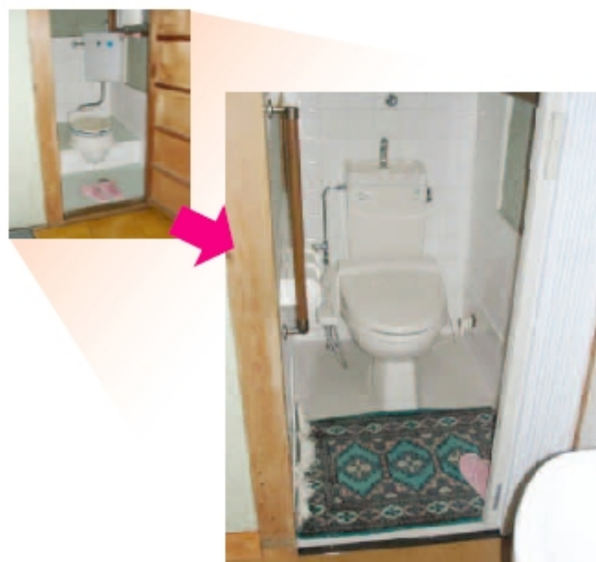
(写真③) 洋式便器等への便器の取替え
