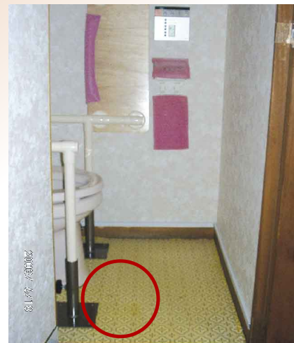
(写真⑨) 改修後
