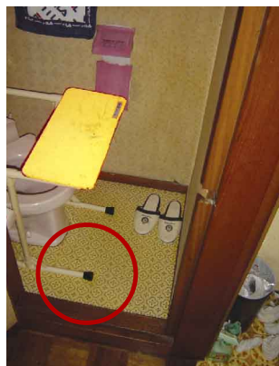
(写真⑧) 改修前
